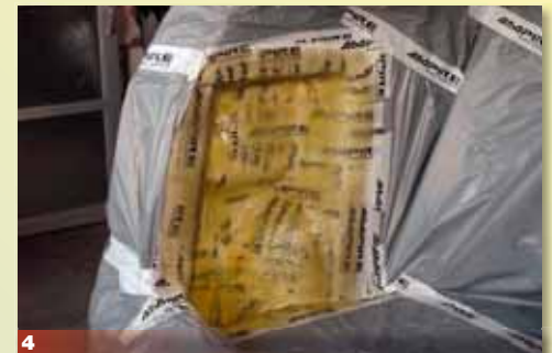
4 Es werden so lange Matten auflaminiert, bis die erforderliche Materialstärke von ca. 5 mm erreicht ist
